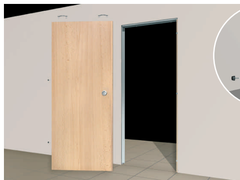
6. Colocación de los toques de goma y pletinas superiores. Fitting the rubber stops and upper brackets. Pose des butées en caoutchouc et des platines supérieures.
