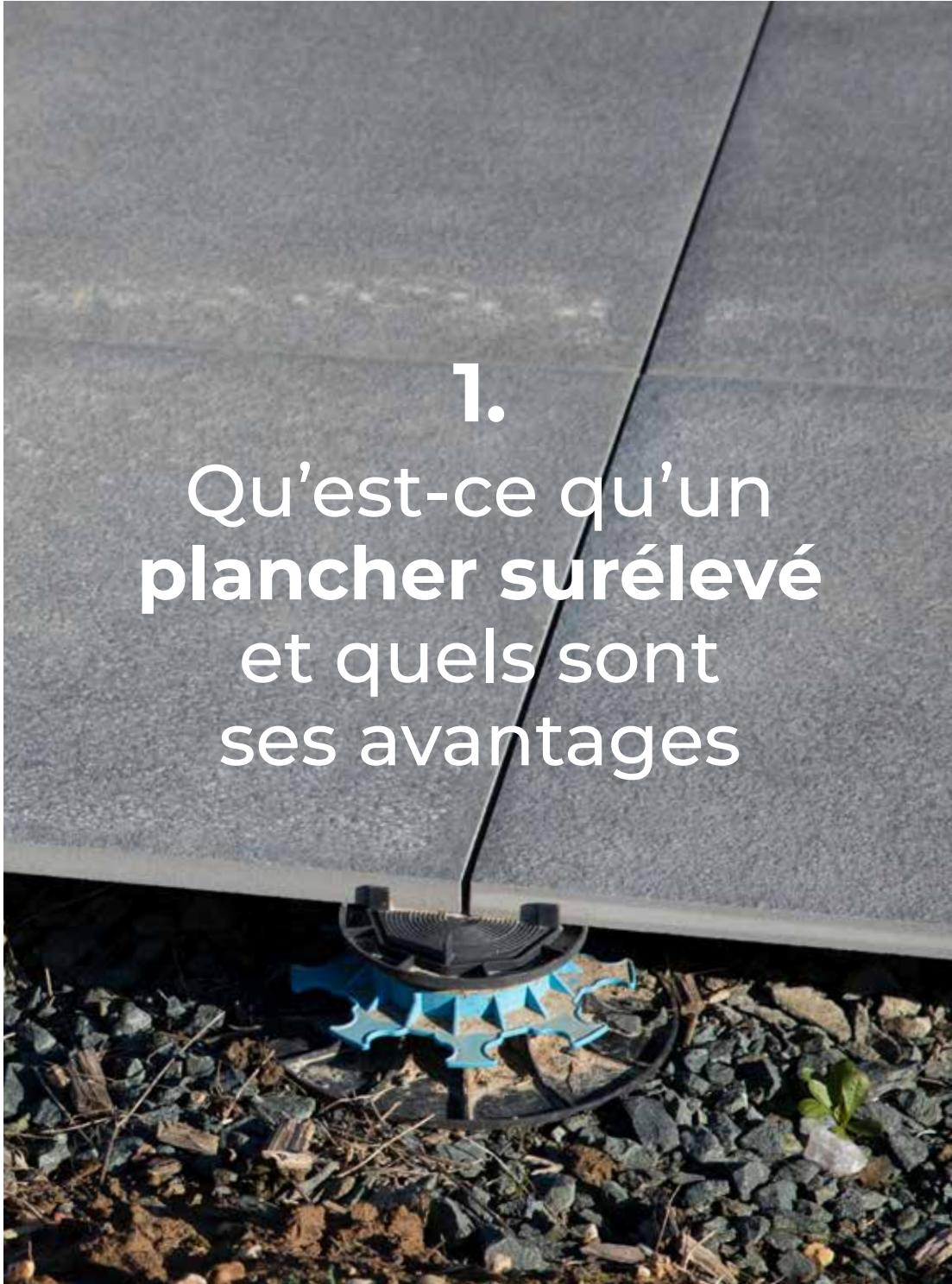
Les planchers surélevés, également appelés sols techniques ou accessibles, sont un système composé de **panneaux modulaires soutenus par une structure de support surélevée**.
