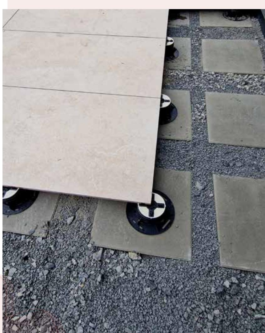
**Os pavimentos elevados** oferecem-lhe uma grande variedade de benefícios. Não só se encaixam suavemente em terrenos irregulares, como existem inúmeros tipos de pavimentos para colocar. Tudo devido à sua flexibilidade e versatilidade, duas características que tornam possível a sua instalação tanto no interior como no exterior.
